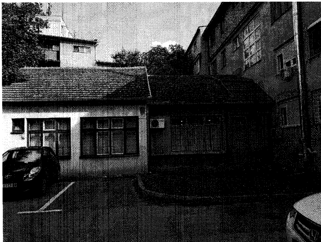
Slika br.2 Aneks stambenog objekta u kojem se nalaze prostorije RFZO – južna fasada
