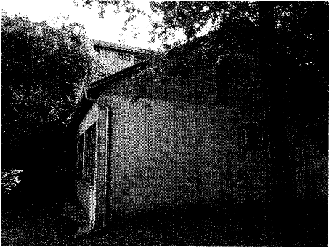
Slika br.3: Aneks stambenog objekta u kojem se nalaze prostorije RFZO – zapadna fasada
