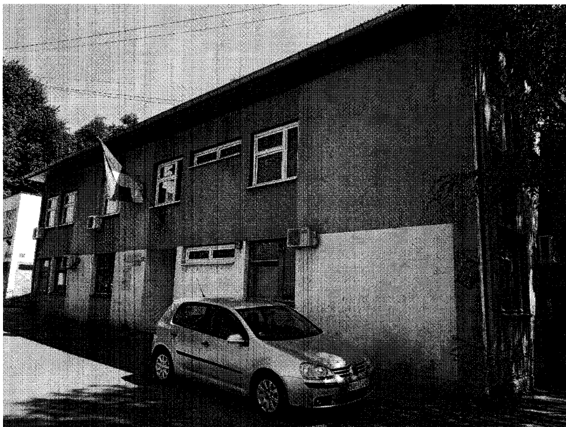
Slika br.1: Zapadni izgled fasade
